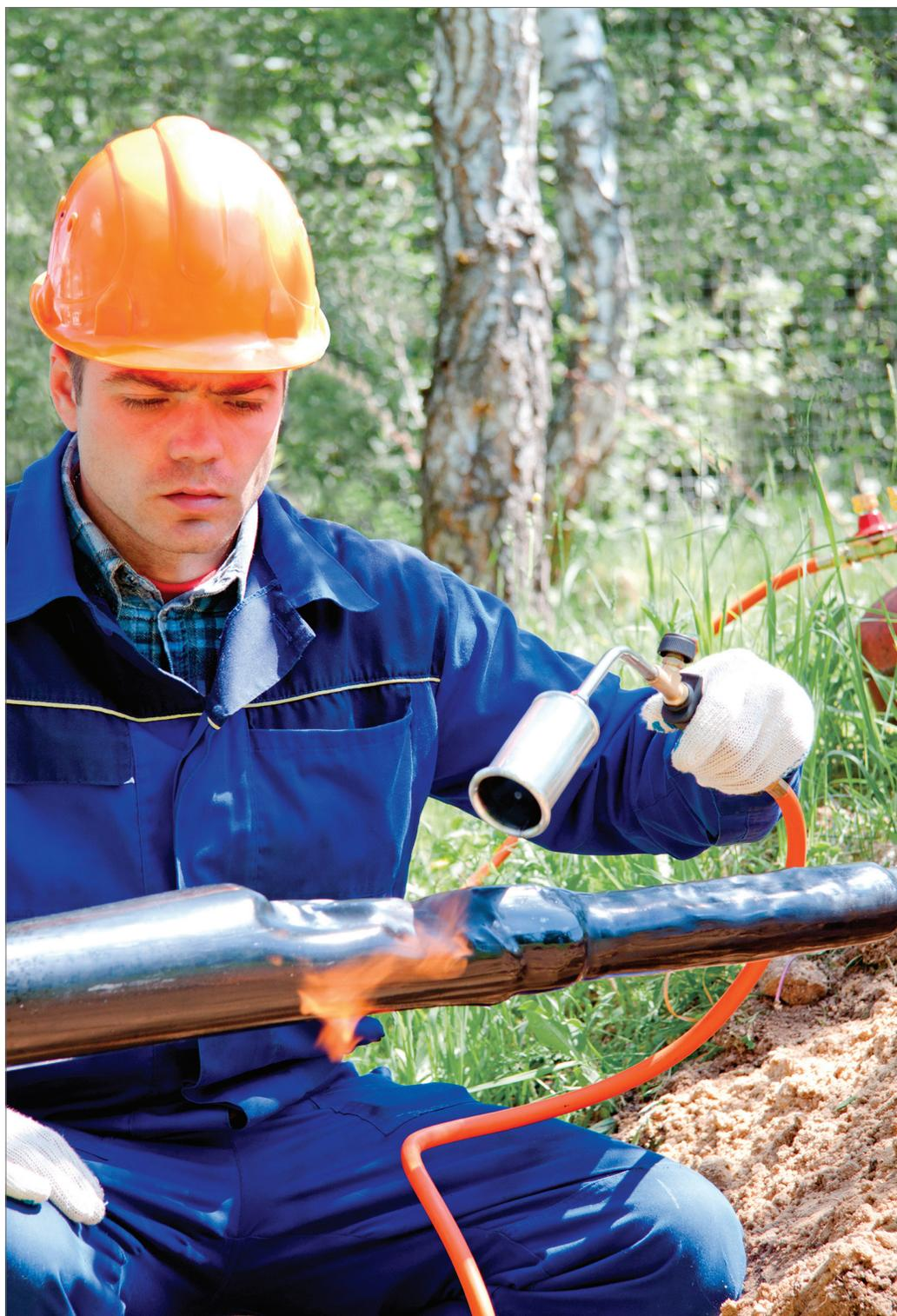
**Термоусаживаемые муфты для контрольных кабелей на напряжение 1 кВ**
